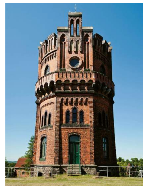
Der Wasserturm Neumühle ist das älteste technische Bauwerk der Schweriner Wasserversorgung, das noch in Betrieb ist.
