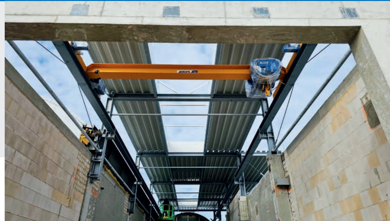
Die Stahlstützenkonstruktion ist fertiggestellt, die Krananlage installiert (18.03.2024).
