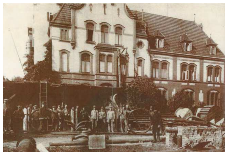
Einführung von Wärmeleitungsrohren am Pfaffenteich, 1924
