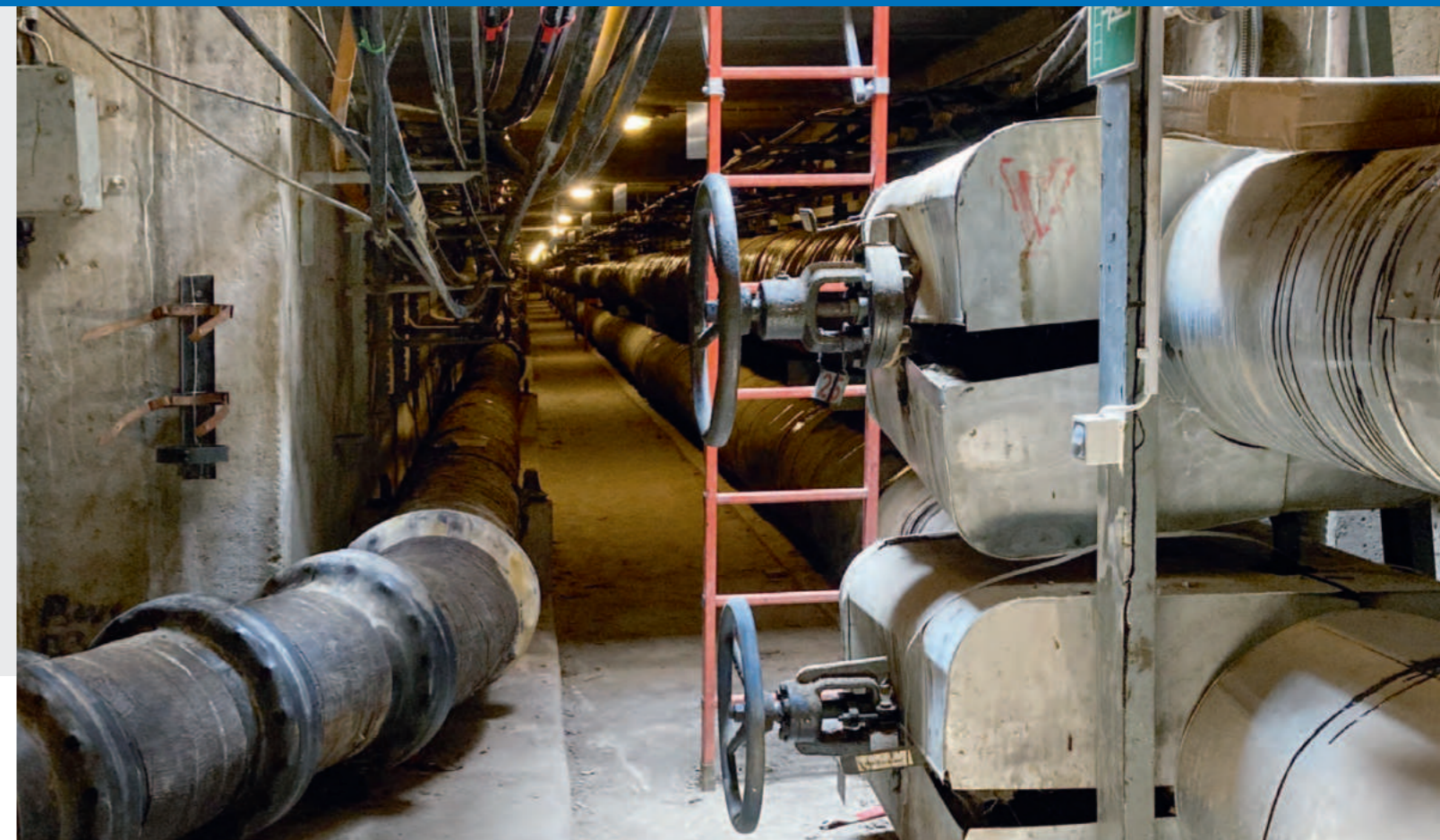
Arbeiten auf beengtem Raum: Hier der Blick vom Zustiegsbereich des Kollektors
