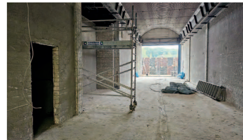
Baufeldfreimachung (Rückbauarbeiten) Stand 10.10.2023
