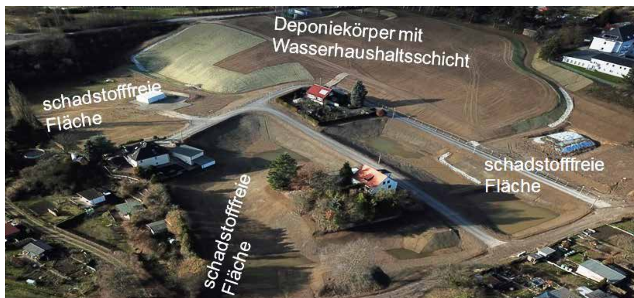
Sanierung der Deponie Finkenkamp startete mit umfangreichen Bodenumlagerungen vor Ort
