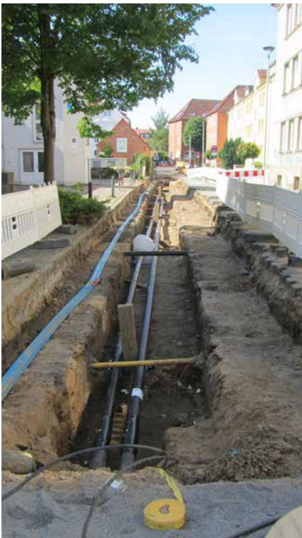
Fernwärmeausbau mit Verlegung von Glasfaser in der Lortzingstraße
